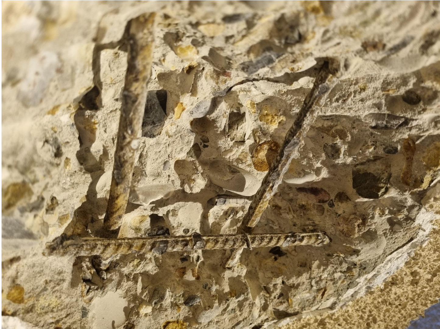
Type d'armature dalle de béton – armatures principales et de répartitions de type crénelées
